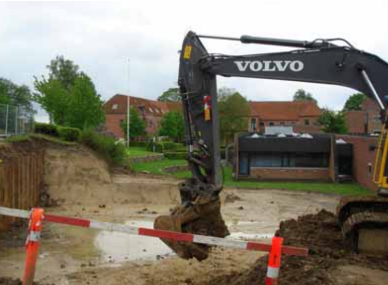
Fra skolens byggeplads i maj
